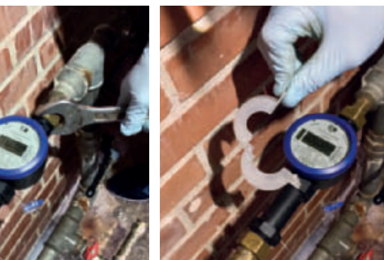
En tekniker fra Tårnby Forsyning i færd med at udskifte en mekanisk måler med en fjernaf-læst måler.
