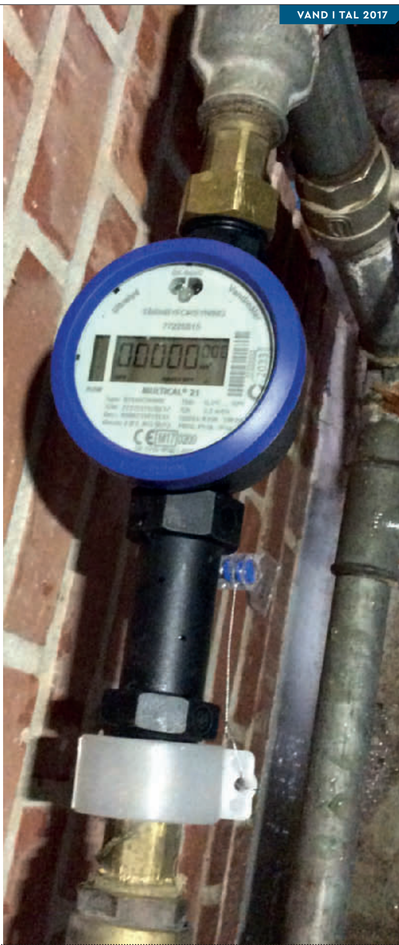
En tekniker fra Tårnby Forsyning i færd med at udskifte en mekanisk måler med en fjernaf-læst måler.
