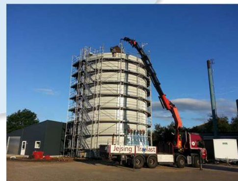
Akkumuleringstank
